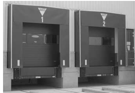
Klappkeil-Überladebrücke mit Torabdichtung
