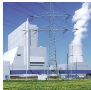
Kraftwerkstechnik Power industry Energie
